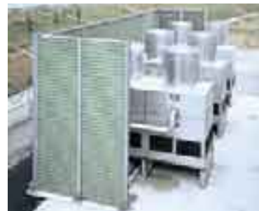
Barriere realizzate a protezione di impianti o macchinari
